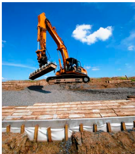
De machinist is bezig de blokken van de dijkbekleding te kantelen.
