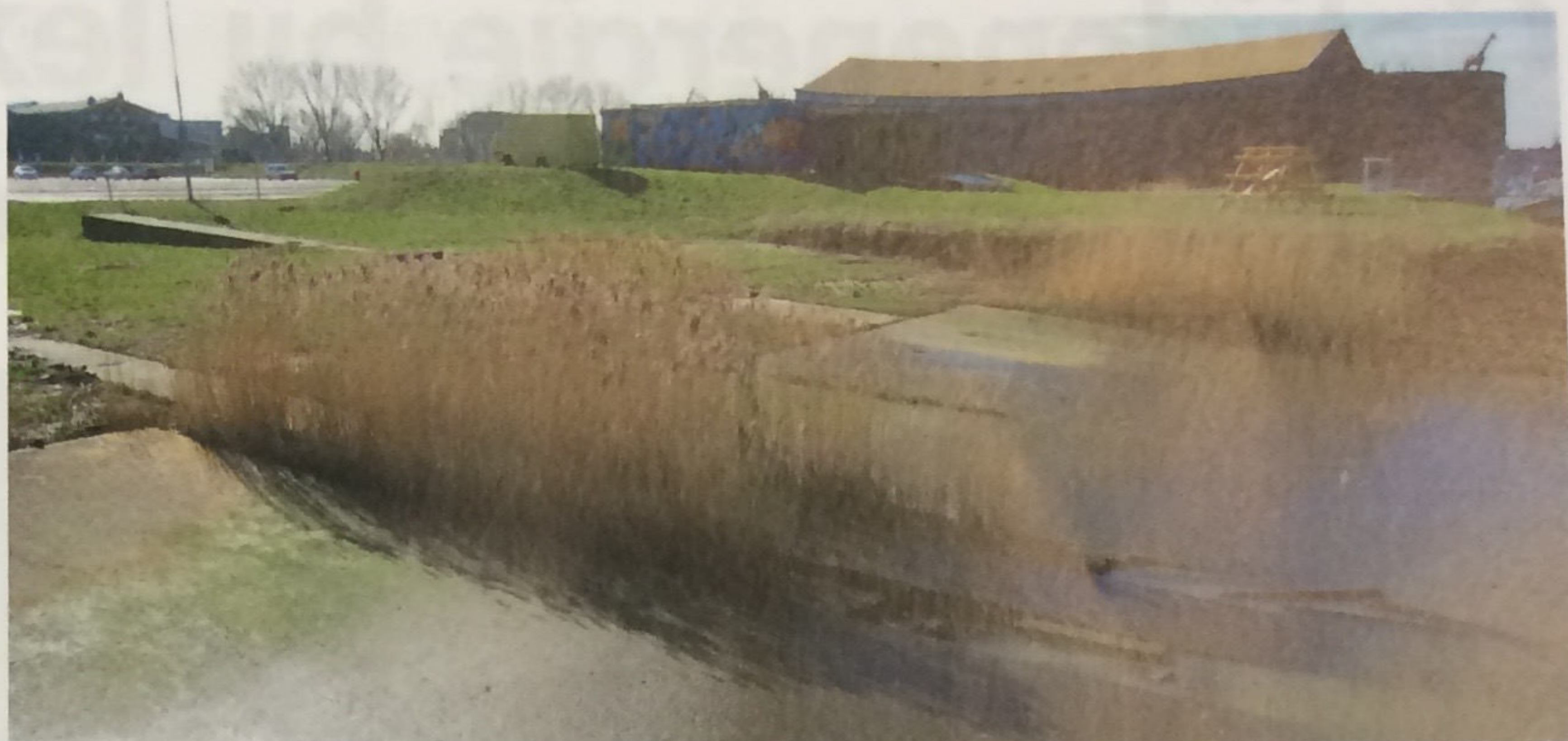
De oever bij Stadswerven loopt geleidelijk af. Betonplaten voorkomen natuurlijke vorming van begroeiing.
