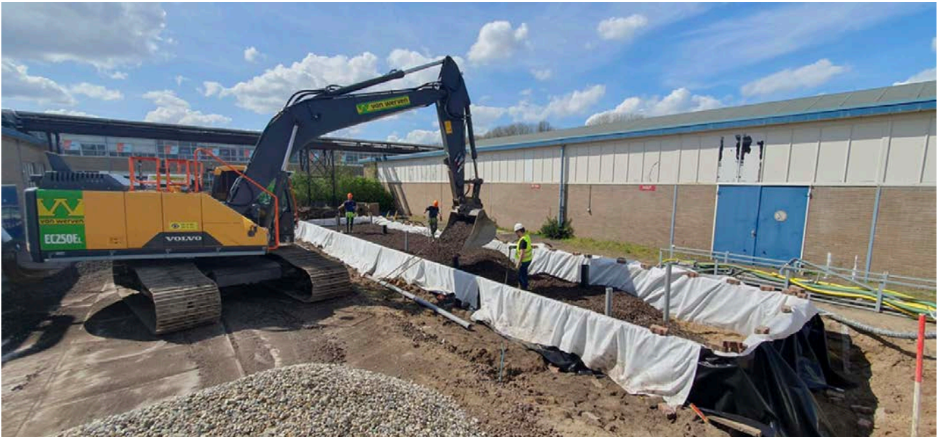
Foto: Aanleg helofytenfilter voor behandeling van met chloorkoolwaterstoffen verontreinigd grondwater in Zwolle. (Bron: Bioclear earth)
