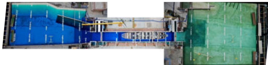
Aanleg nieuwe zeesluis IJmuiden: noodzakelijke technische renovatie gekoppeld aan nieuwe functie-eisen (grotere schepen) (Bron bovenste foto: Rijkswaterstaat)
