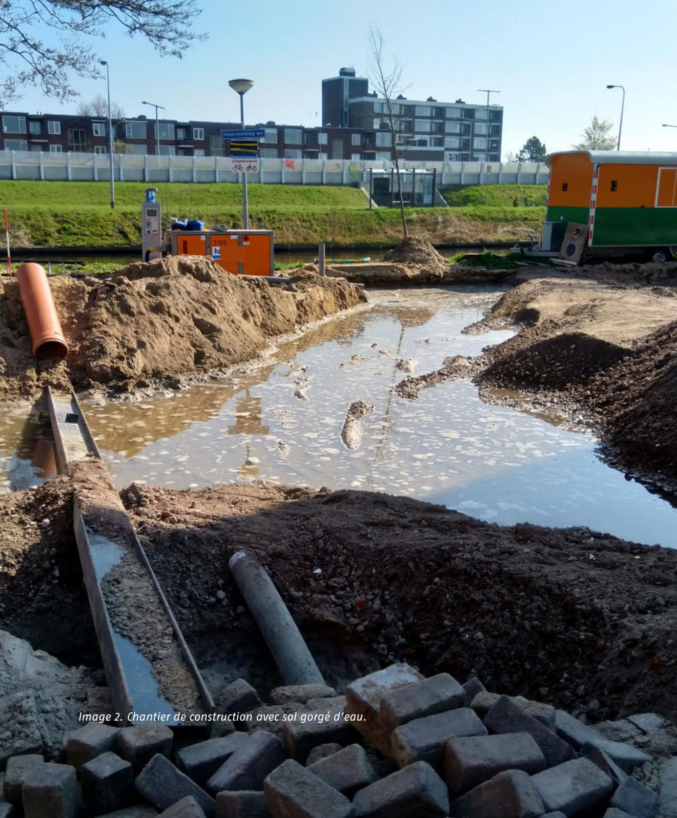
*Image 2. Chantier de construction avec sol gorgé d'eau.*
