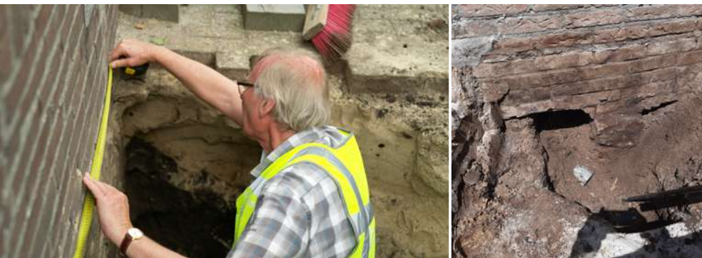
Figuur 4 Inspectie in de gegraven put (foto links) en de aangetroffen fundering (foto rechts)
