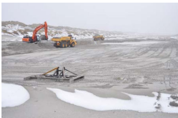
Figuur 23. De lagere delen van Spanjaards Duin worden verdiept in de winter 2018-2019. Er is ca. 36.000 m 3 zand afgevoerd richting het natte strand ten noorden van slag Vlughtenburg.
