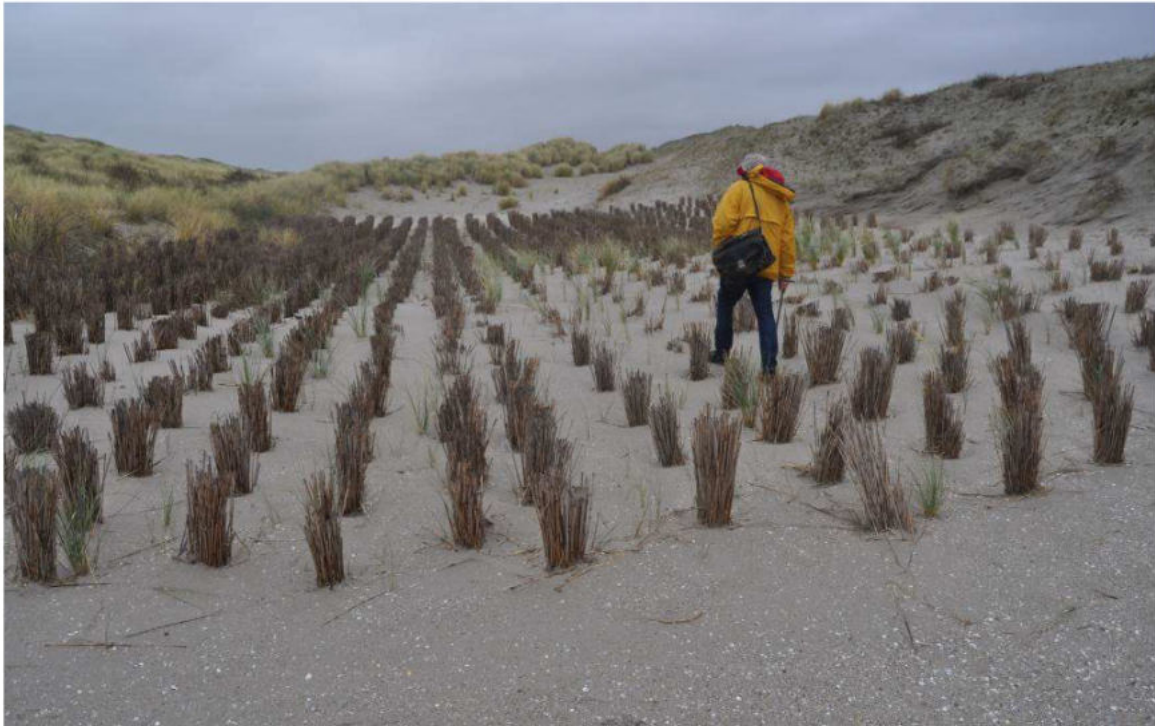
Figuur 8. Rietpoten vak A, 1,5 jaar na aanleg (foto 2017).
